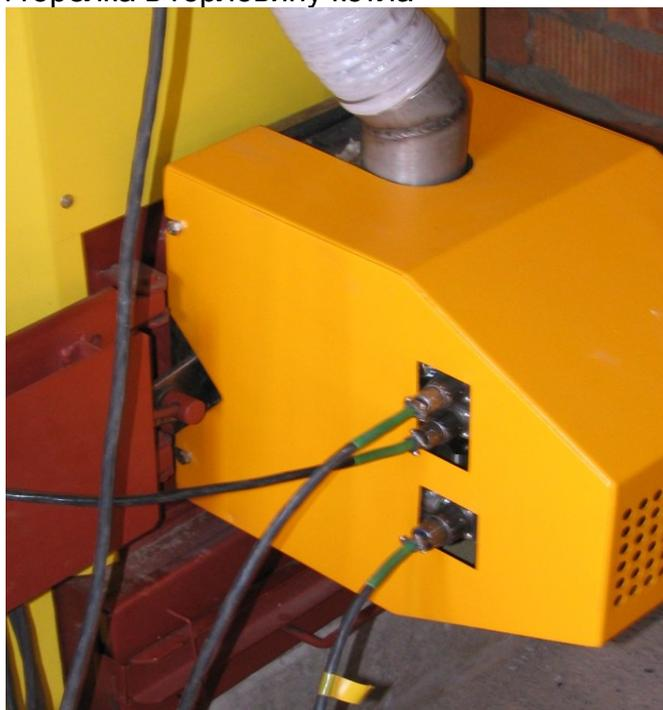
Во время работы пеллеты из бункера подаются в горелку с помощью механизма подачи, оборудованного шнеком.
